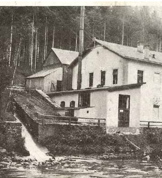
Elektr. Centrale im Kamptal.
